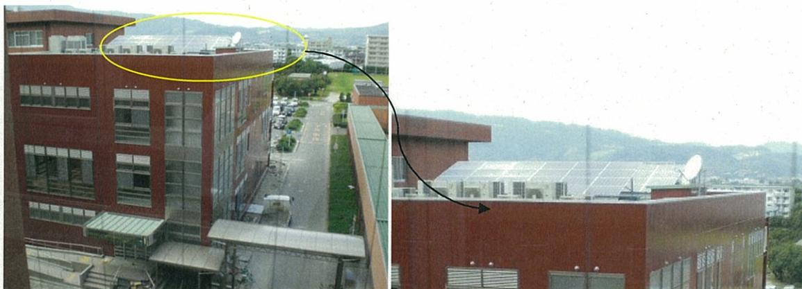
建設中の新しい卒後臨床研修センターの屋上には太陽光発電パネルが設置されています。
